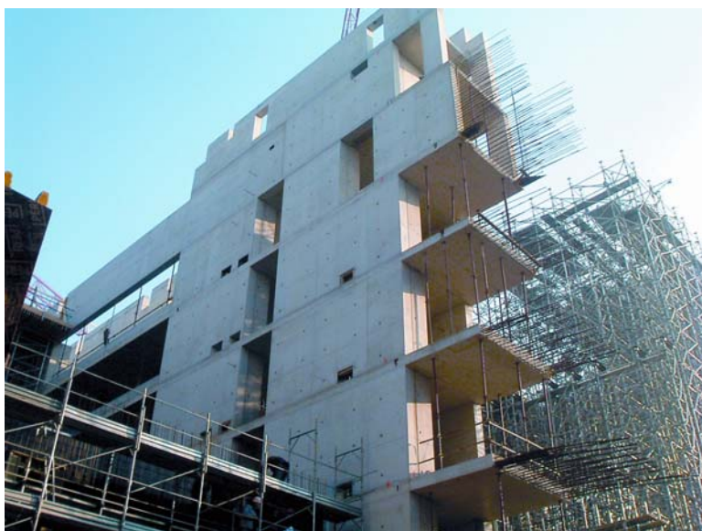
Fig. 1 - Panoramica del cantiere in via Bligny.
