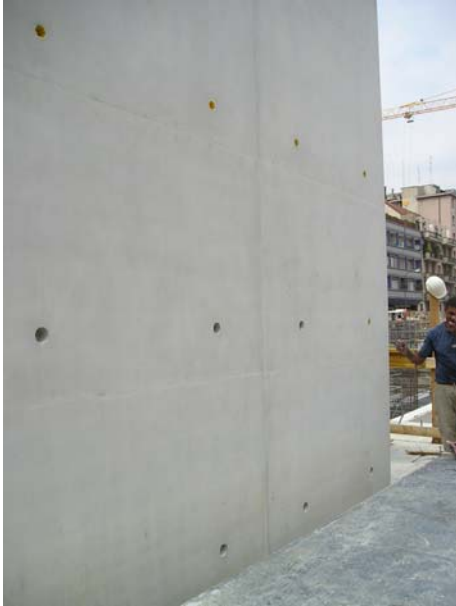
Fig. 7 - Dettaglio del pilastro.
