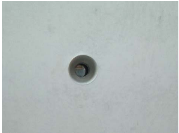
Fig. 8 - Dettaglio del faccia a vista
