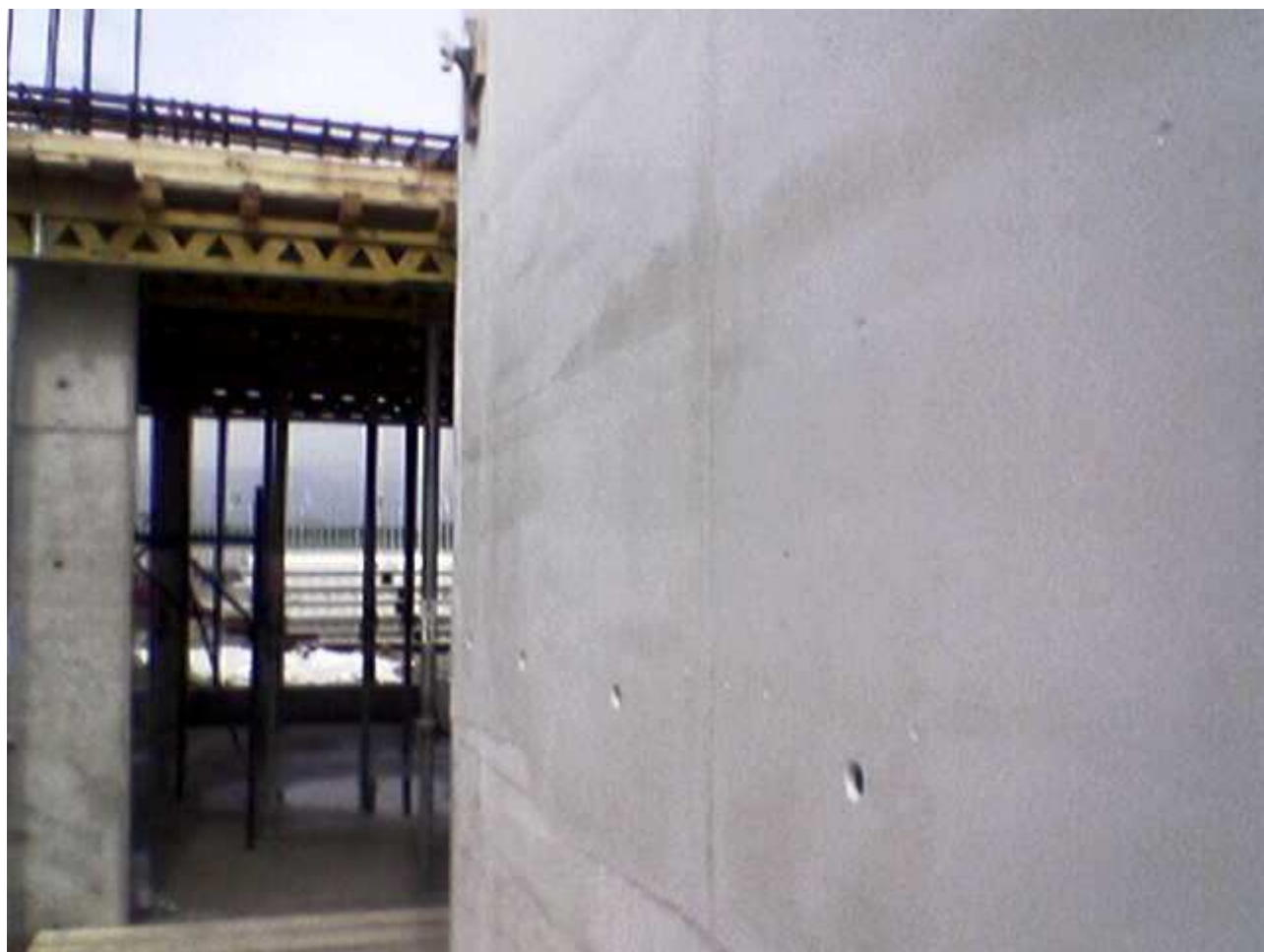
Muro gettato in opera in SCC bianco
